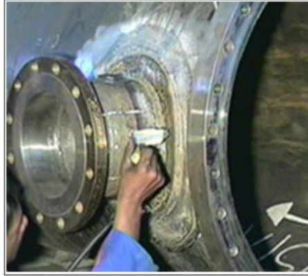
Figura 49 - Teste de estanqueidade em uma conexão
